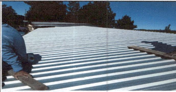
Foto 5: instalación de lamina troquelada
